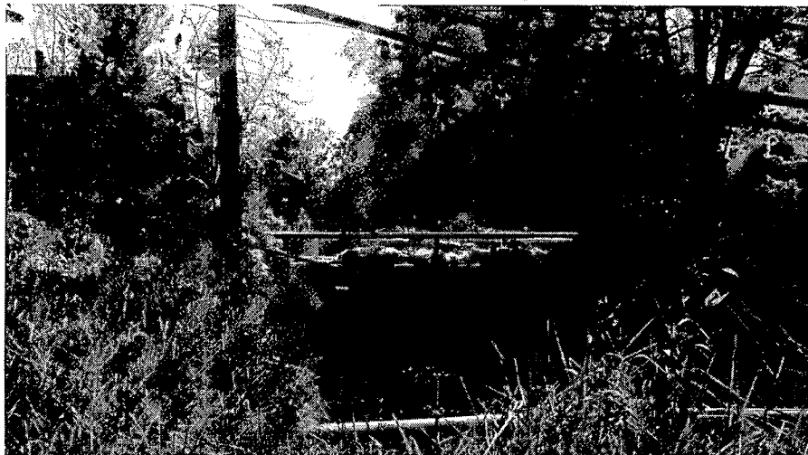
Fotografía 2. Puente ubicado sobre el antiguo cauce del Río Bogotá, el cual comunica las 2 instalaciones de la empresa EMPACOR S.A.
